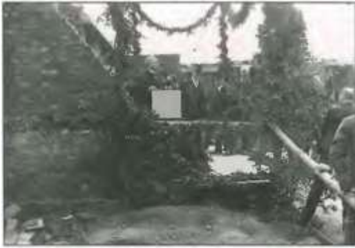
Abb. 163: Grundsteinlegung des Jugendwohnheimes, Frühjahr 1953
