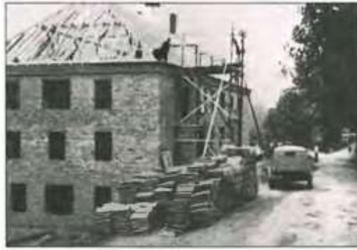
Abb. 164: Rohbau des Jugendwohnheimes, 1954
