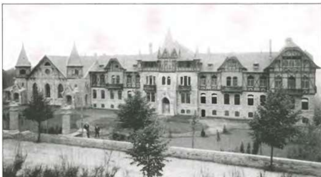
Abb. 10: Invaliden- und Genesungsheim für Arbeiter in Grundschoßel bei Volmarstein („Sanatorium“), später Knappschaftsgenesungsheim
