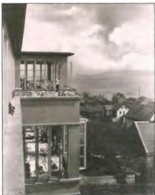
Abb. 157: Luft- und Lichtveranda
