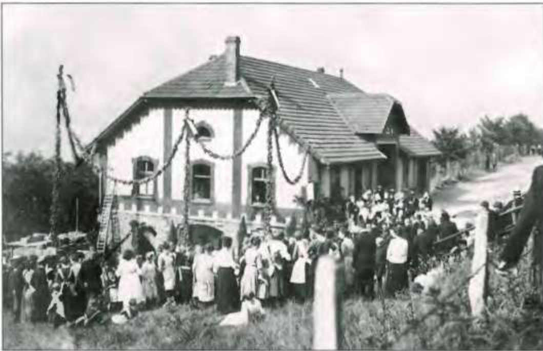
Abb. 60: Beginn der Umbauarbeiten zum Franz-Arndt-Haus, 1922
