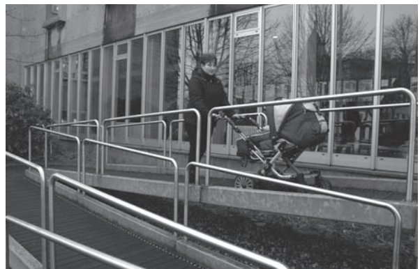
Barrierefreies öffentliches Gebäude in Dortmund dank Rollstuhl- und Kinderwagenrampe
