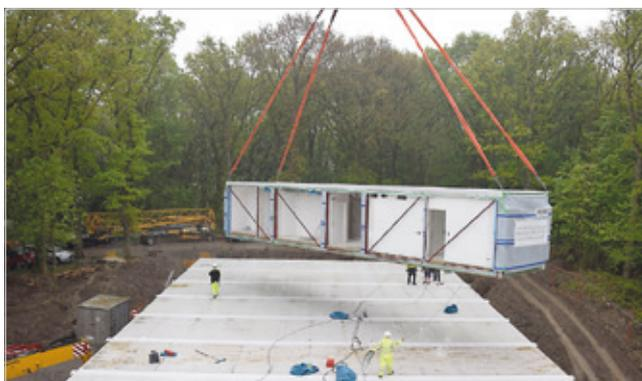
**April.** Nachdem seit April die Bagger für den Umbau bzw. den neuen Anbau des Krankenhauses rollen, kamen nachts die Schwertransporter zum Mops. Tagsüber wurden die insgesamt 52 Baumodule mit einem sehr großen Kran millimetergenau an die passenden Stellen gesetzt. Und es lief alles nach Plan in Haspe. Nach und nach flogen die vorgefertigten Zimmer mit dem Kran an den richtigen Platz. Für dieses Spektakel kam sogar der WDR und berichtete in der Lokalzeit.
